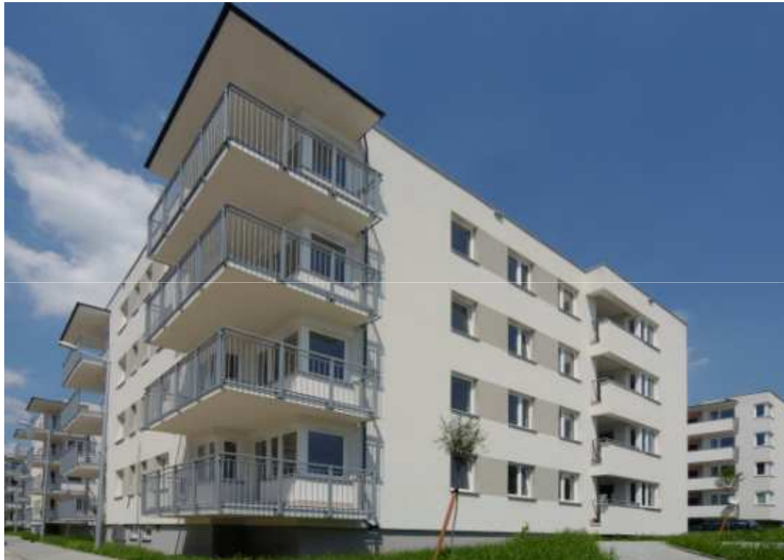
KRAKÓW, Osiedle pod Fortem
